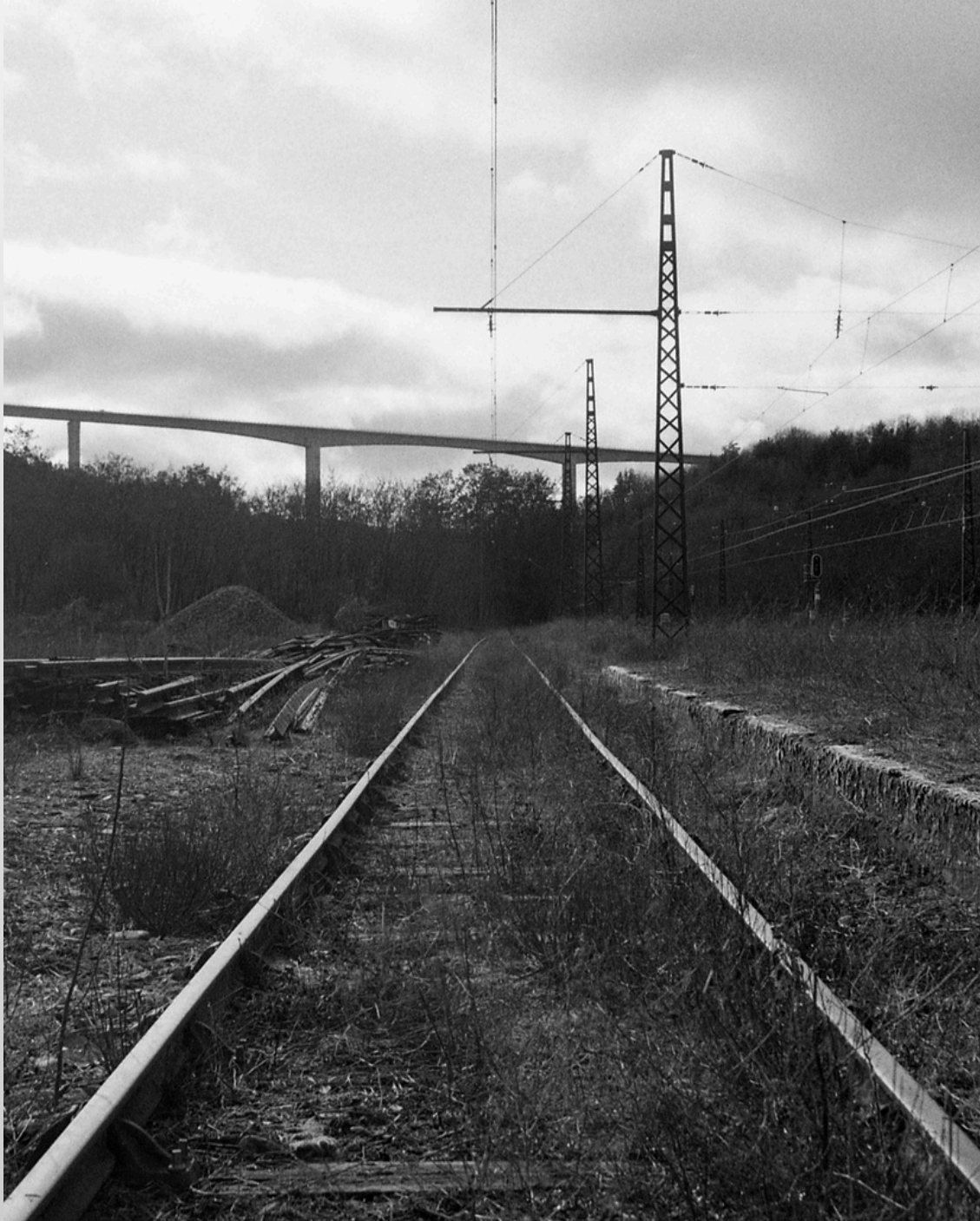
Vue sur le viaduc de la Colagne depuis la voie ferrée à Le Monastier
